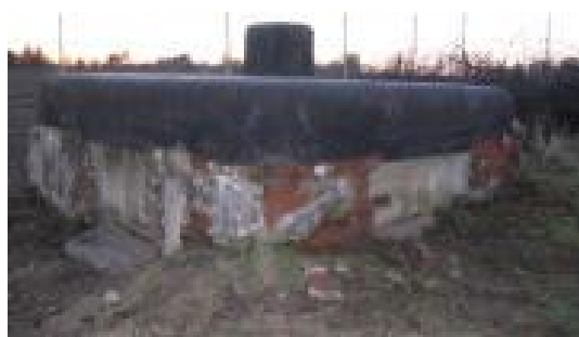
Objekt pohledem z východu
